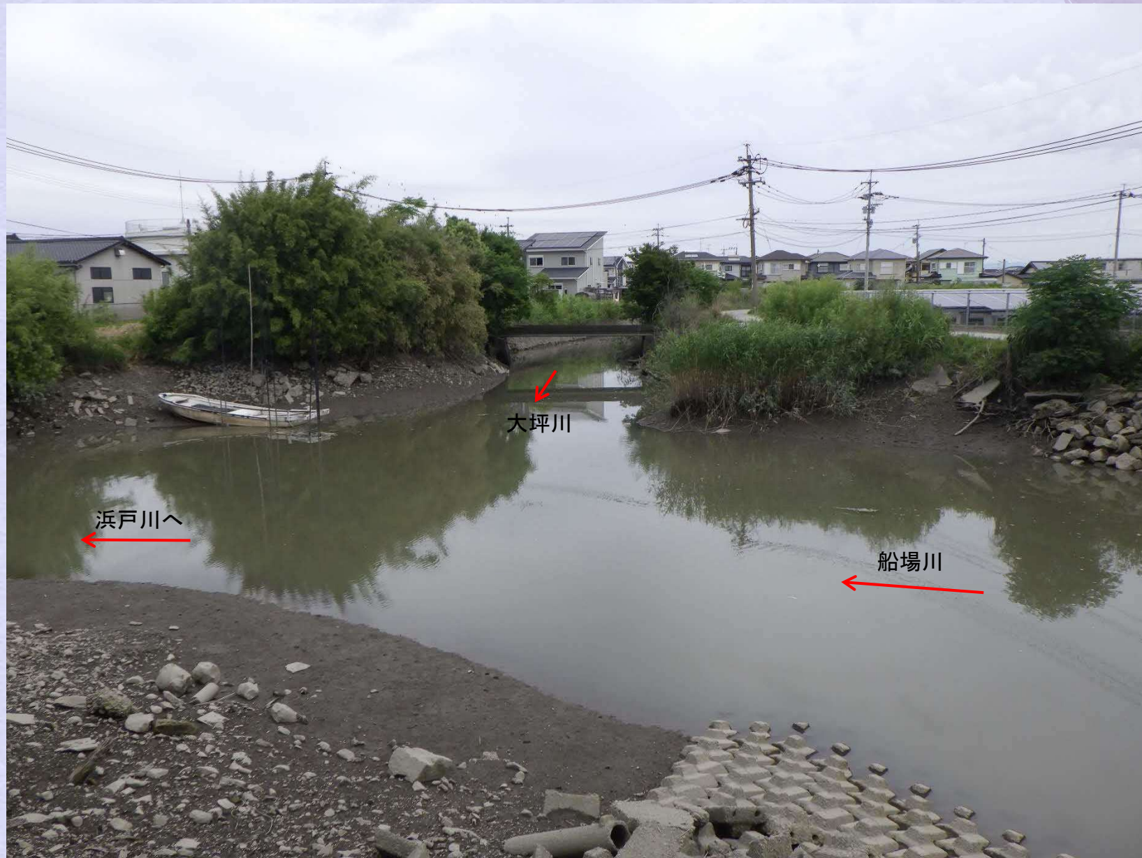
⑦ 最下流部状況(船場川合流点)
