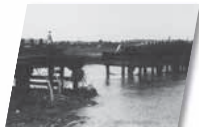
■豪雨により流失した平木橋
