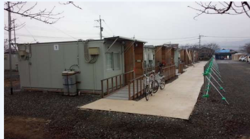
応急仮設住宅完成
