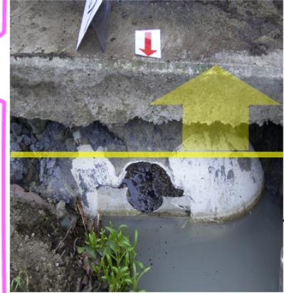
浄化槽が浮上して流入管が外れている
