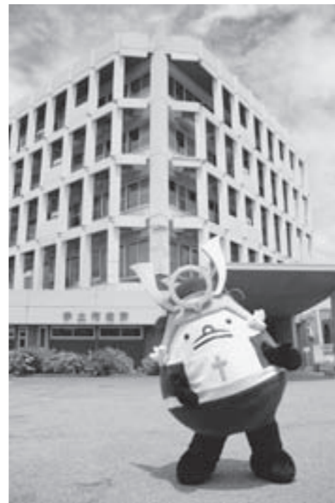
昭和40年に建設した市庁舎
