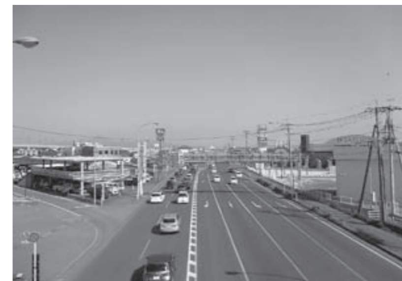
松原交差点から見た宇土駅東口方面
