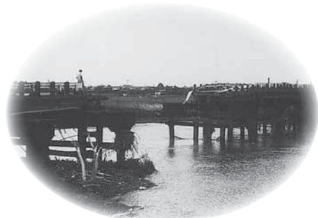
■豪雨により流失した平木橋
