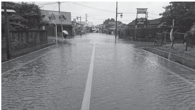
旭町～南段原間の水害被害状況
