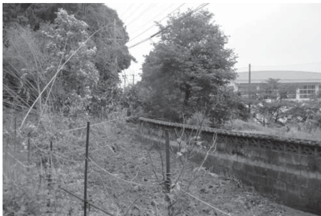
土砂により塞がれている通学路
