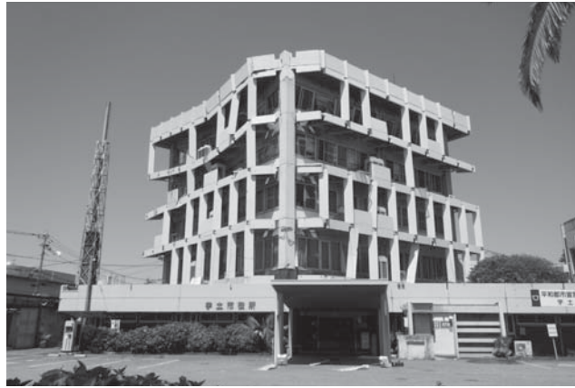
大地震で被災した本庁舎
