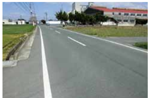
外側線が補修された道路
