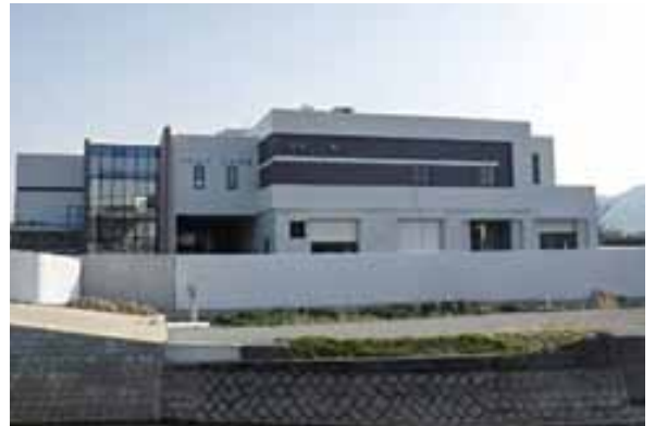
完成した環境再生センター(KIREKA)
