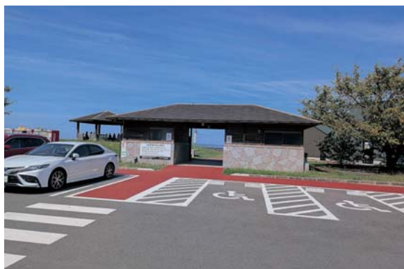
公園トイレと東屋付近
