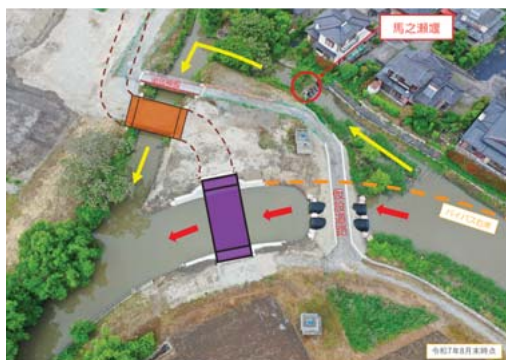
大坪川の工事の進捗状況
