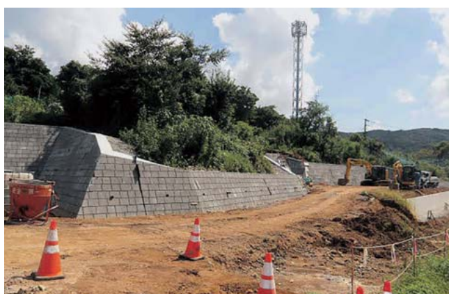
干潟景勝地展望広場整備事業の工事の様子
