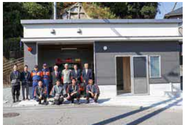
完成した第3分団第3班格納庫
