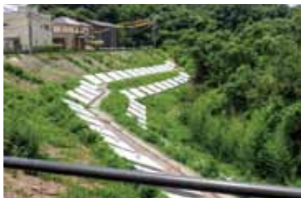
完了した地滑り防止工事
