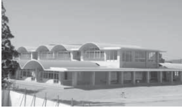
完成した網津小学校新校舎
