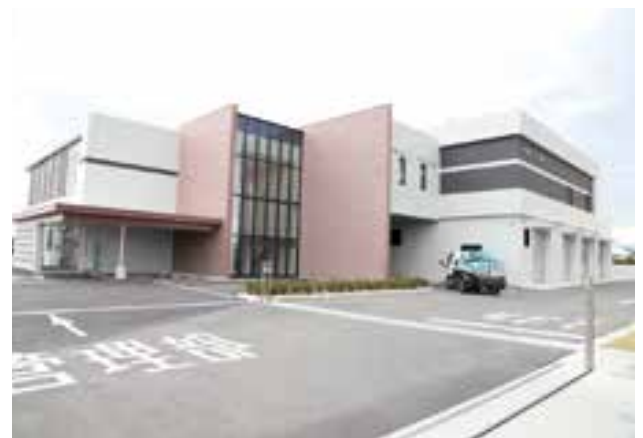
完成した「環境再生センター KIREKA」
