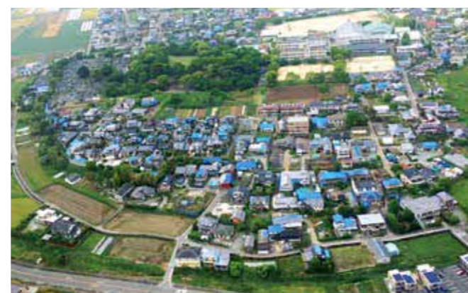
避難指示が発令された轟地区
