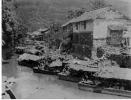
船で生活する避難者(熊本市高橋町)
