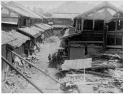
倒壊した家屋(熊本市高橋町)
