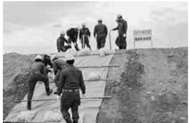
シート張り工法
