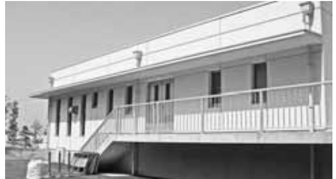
完成した戸口浄化センター
