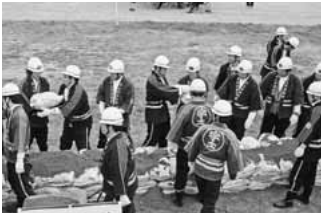
土のう積み工法
