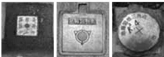
図根点ボックス 地籍図根三角点
