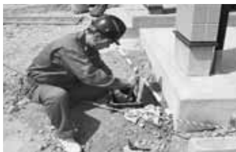
メーター器交換状況
