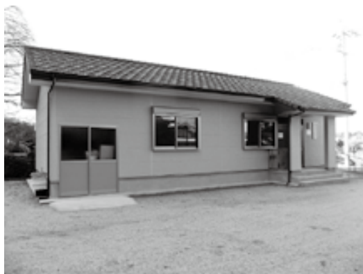
整備された中村区コミュニティセンター
