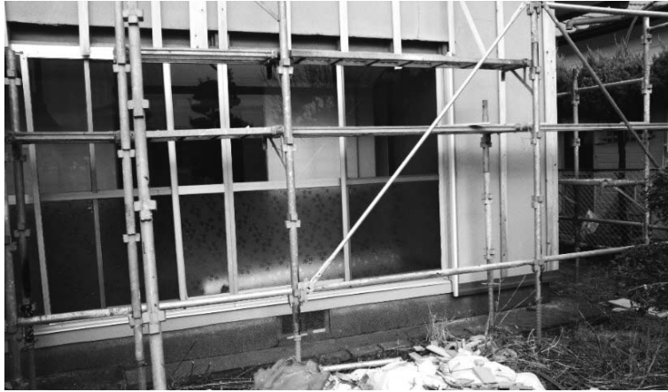
地震後、戸建て木造住宅の耐震改修状況
