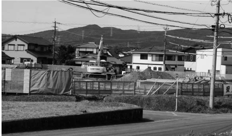
災害公営住宅建設中(境目町)
