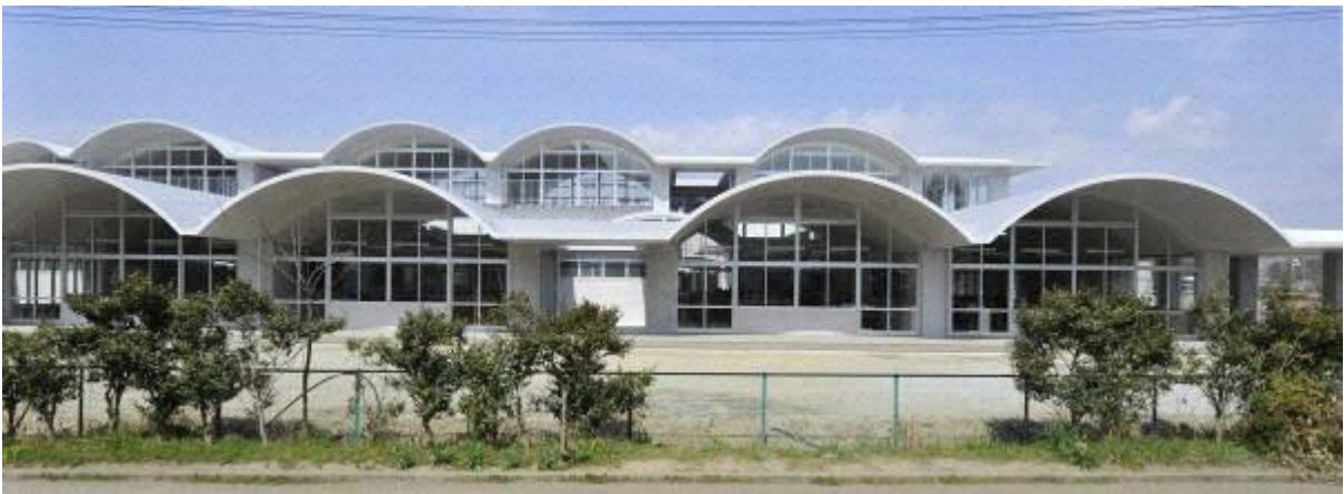
網津小学校校舎（平成23年3月竣工）
