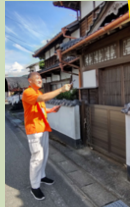
市内の空き家を外から調査中！
