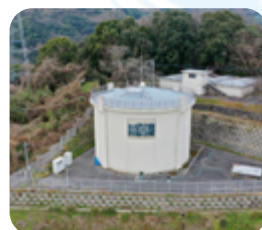
第1配水池(轟配水池)
