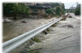
【豪雨災害による河川氾濫】
