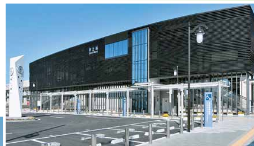
●新しくなった宇土駅西口広場。中心市街地に通じる宇土駅本町線も含め駅西側が再生。
