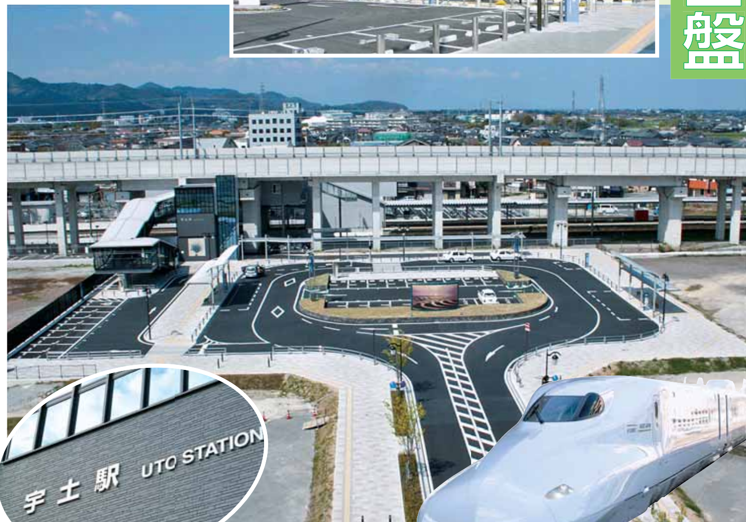
●国道3号側からの利用が可能となった宇土駅東口広場
