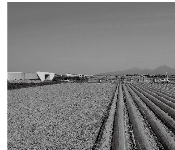
建設中の熊本宇土道路と田園
