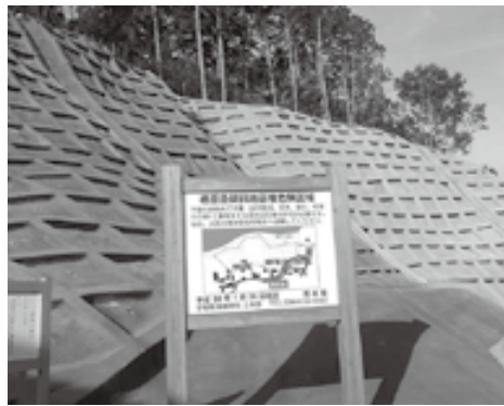
整備完了した急傾斜地崩壊危険箇所の様子
