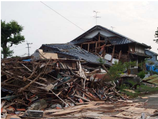
図 住宅の倒壊状況
