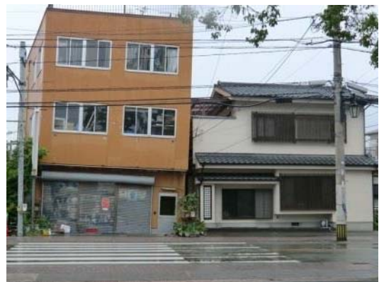
図 液状化による建築物の傾斜
