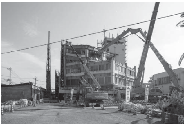
市役所の解体工事
