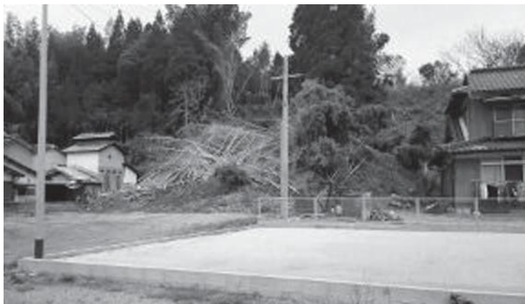
地震により亀裂が走り大雨によって崩壊した椿原町の崖
