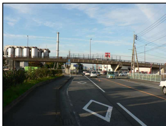
松山橋（跨道橋）
