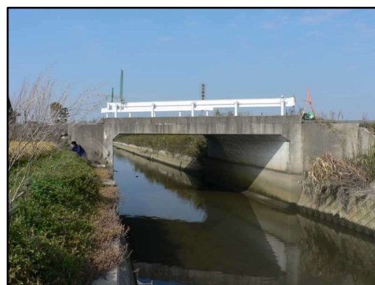
新開 28 号橋（ボックスカルバート）
