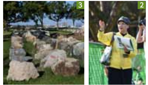
1_複数箇所ですり壊れ、石垣が損壊(写真は戌亥櫓) 2_修復中の熊本城を案内するボランティアガイド 3_同じ位置に復元するため整理された崩れた石垣
