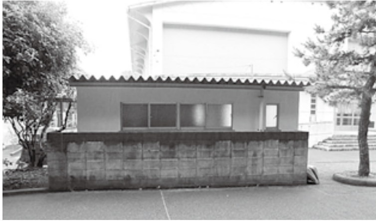
撤去予定の目隠しブロック塀
