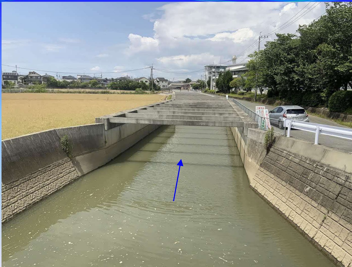
⑤ 腐食の激しい鋼矢板を、コンクリート矢板護岸により改修した区間 ：整備後（宇土市武道館裏）H29～R6にかけて整備
