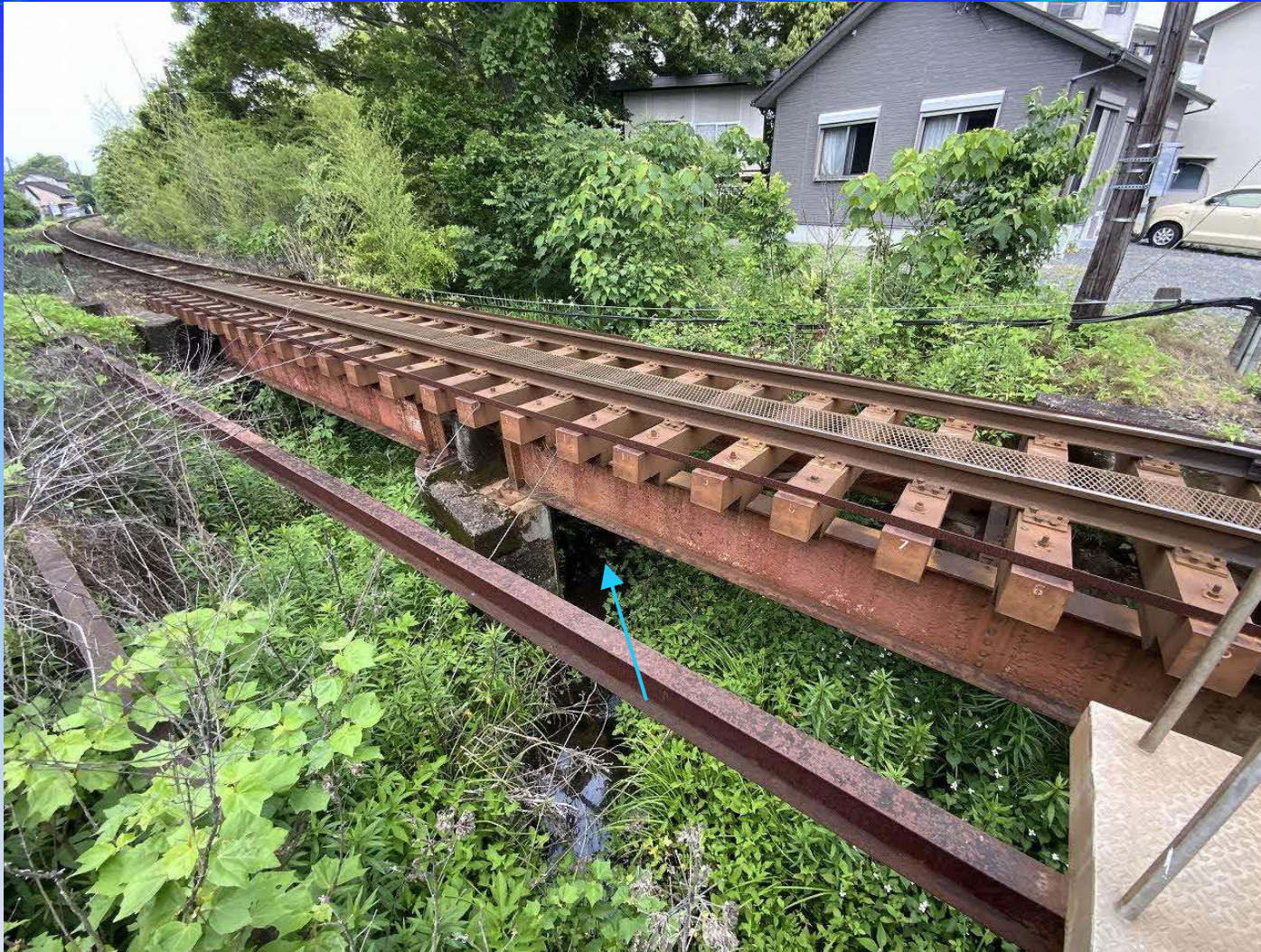
⑦ バイパス河川を横断しているＪＲ鉄橋（２箇所）
