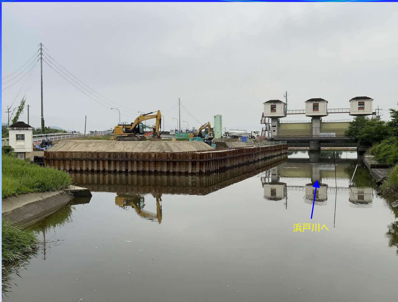
⑭ 松原排水機場（建設中）と船場川水門
