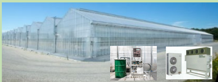
CO 2 貯留・供給装置 ヒートポンプ
