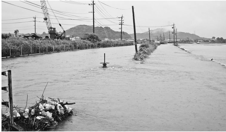
大雨により氾濫した河川
