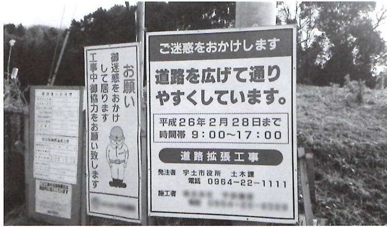
公共工事の立て看板
