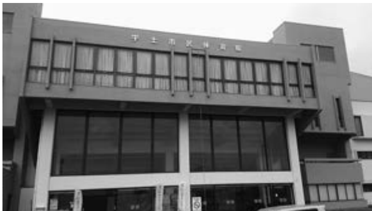
無風空調設備は室内競技誘致に絶好の施設
