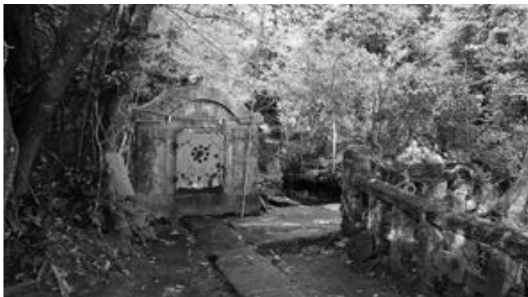
轟泉水道取水口
