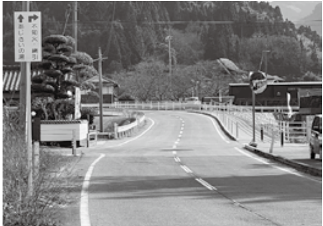
県道58号バイパス延伸の起点 (あじさいの湯付近)
