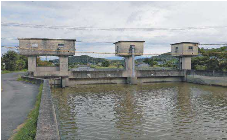
網津川防潮水門
