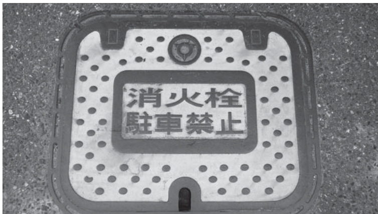
大規模災害に備えた消火栓
