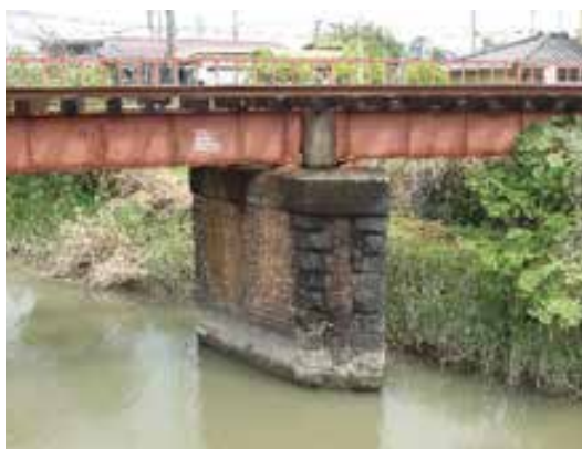
JR三角線の煉瓦造りの橋りょう（築籠町）
