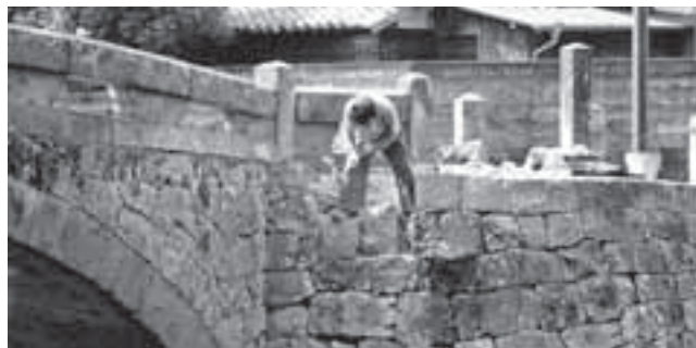
水道管跡を修復
