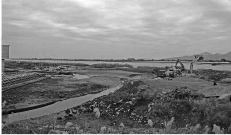
笹原地区船着き場工事風景
