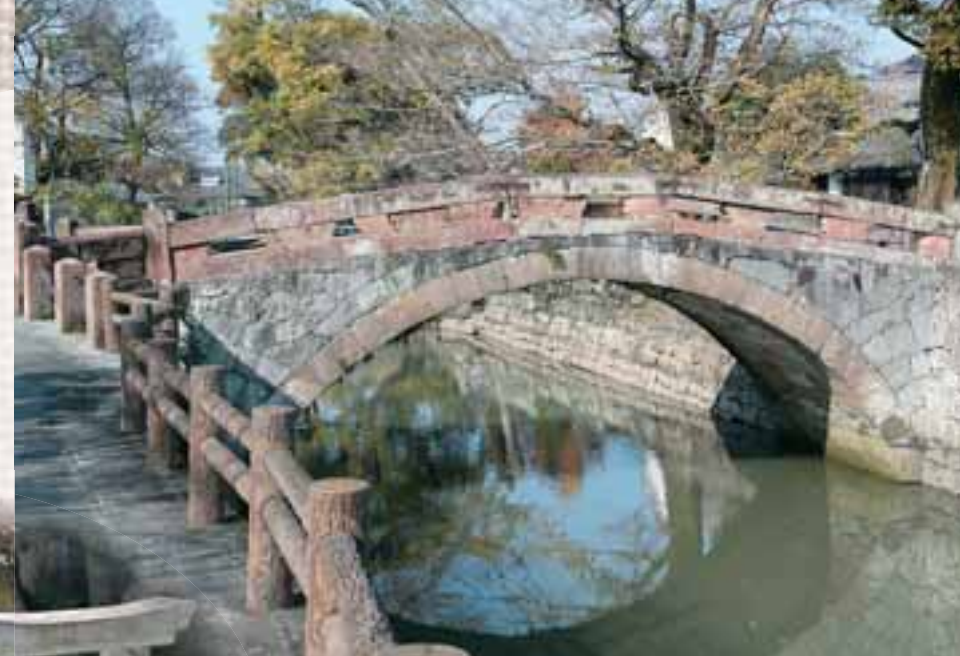
船場橋(めがね橋) 文久元年に架橋され、今なお昔の面影を残す。赤味を帯びた馬門石の輪石が特徴
