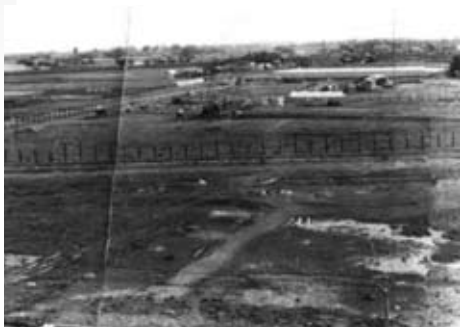
新市庁舎の建設地（浦田町）
