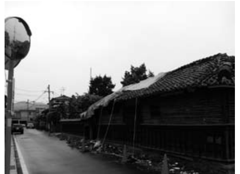
←門内町武家屋敷「旧高月邸」被災状況
