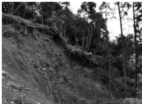
←天神山古墳 墳丘崩落箇所
