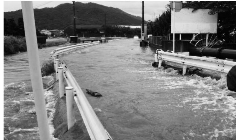
大雨により氾濫する潤川
