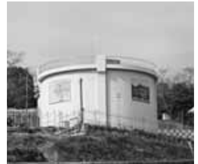
▲宇土市配水池
