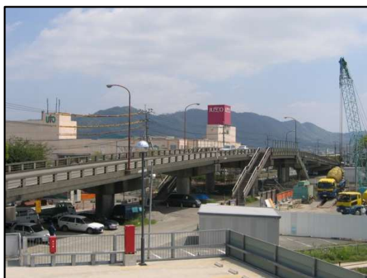
中央線陸橋（跨線橋）
