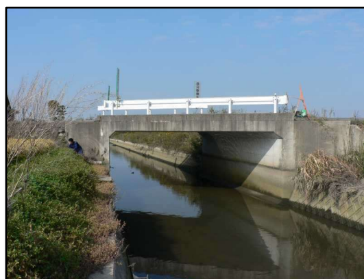
新開28号橋（ボックスカルバート）
