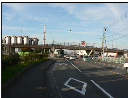
松山橋（跨道橋）
